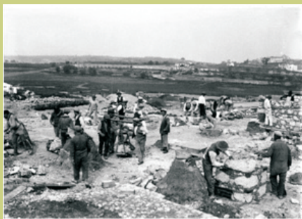
Início das obras de construção do edifício
